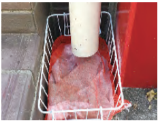
雨どい下に設置したゼオライト。屋根に付着したセシウムを吸着する
